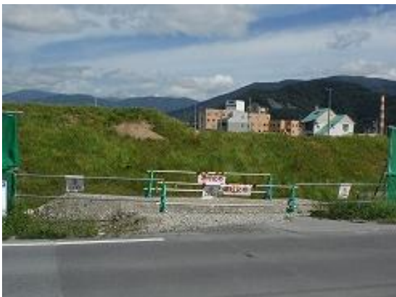
単管バリケードとネットフェンス
