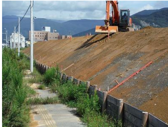
盛土施工時の状況
