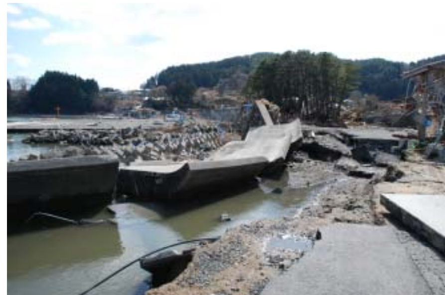
三陸町越喜来 泊漁港付近 破壊された防潮堤
