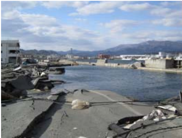
大船渡町 マイヤ本店裏・茶屋前岸壁 破壊された防潮堤
