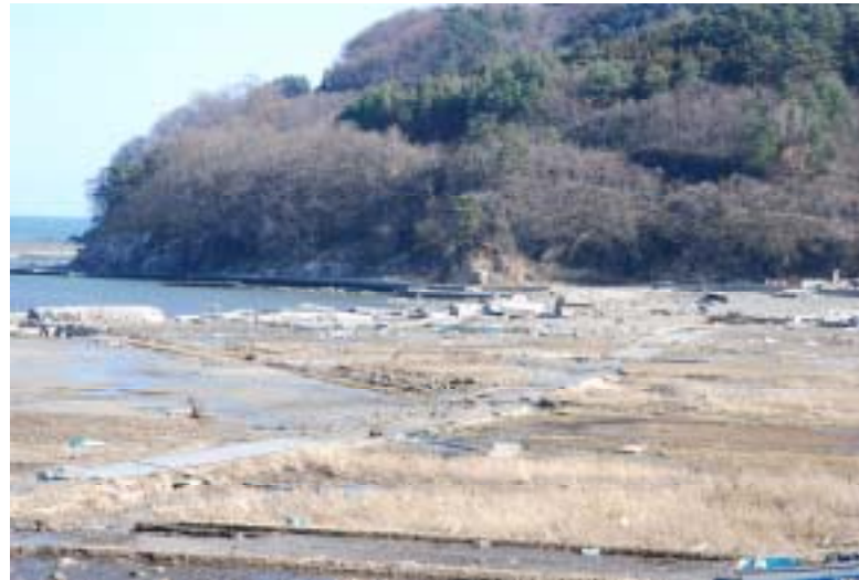
三陸町吉浜 吉浜海岸 破壊された吉浜海岸防潮堤
