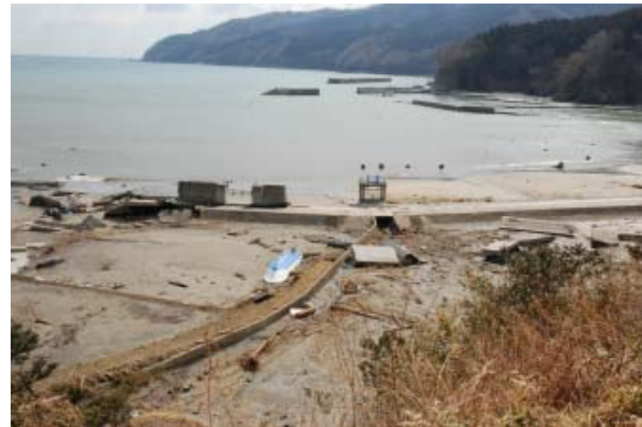
三陸町綾里 野々前漁港・白浜 破壊された防潮堤
