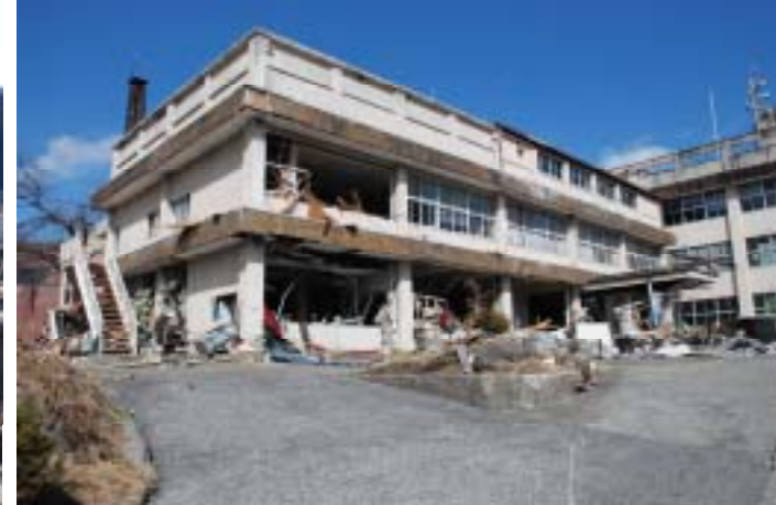
三陸町越喜来 市役所三陸支所 小型漁船等の漂流物が流れ込んだ支所
