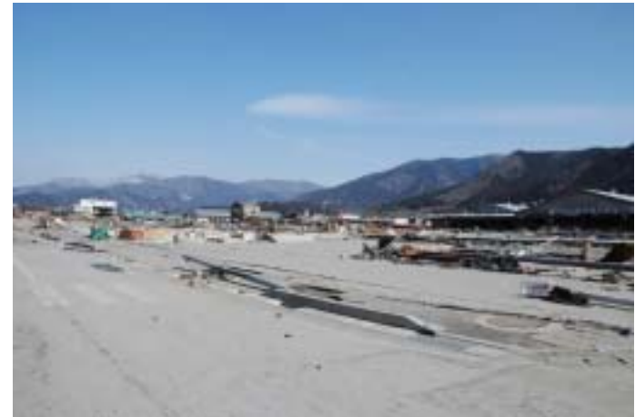
大船渡町 工業団地 工場施設が流失。地盤沈下が広範囲に発生
