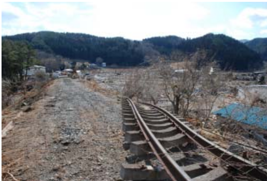
三陸町越喜来 三陸鉄道(泊地域) 津波で軌道が流された三陸鉄道
