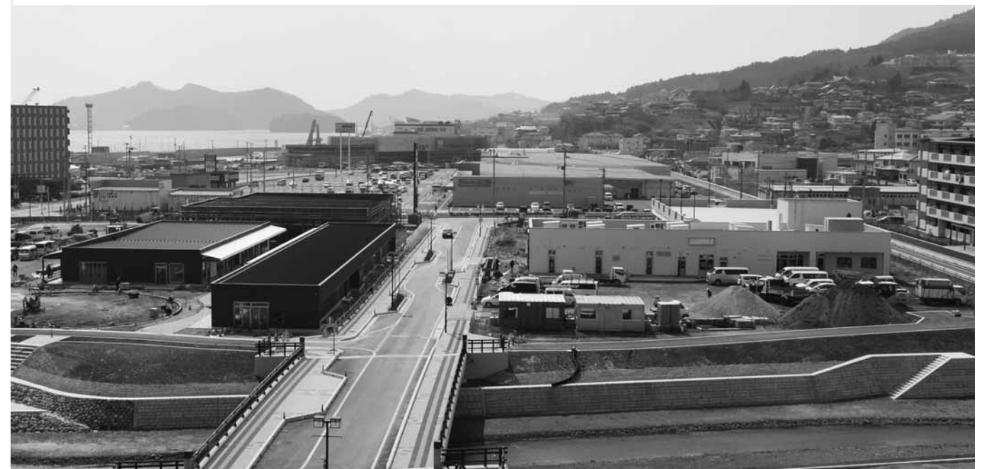
【写真】整備が進む大船渡駅周辺地区
