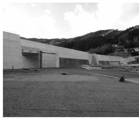
被災した5漁港の水門を整備します
