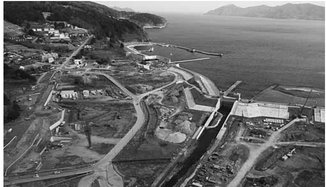
三陸町越喜来浦浜地区の被災跡地に広場を整備します
