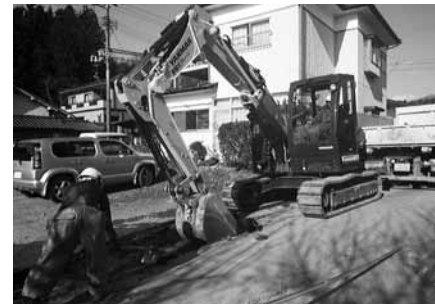
下水道管きょ工事の様子
