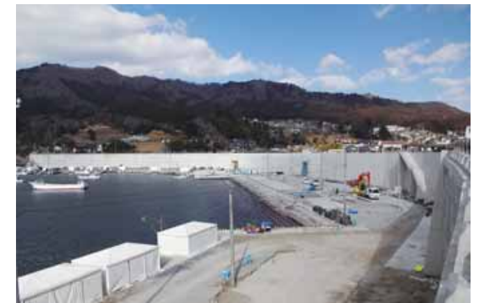
工事が完了した崎浜防潮堤
