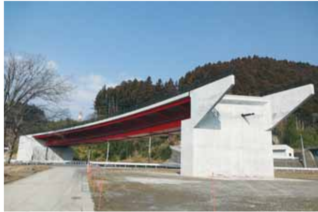
工事が進む主要地方道大船渡綾里三陸線
