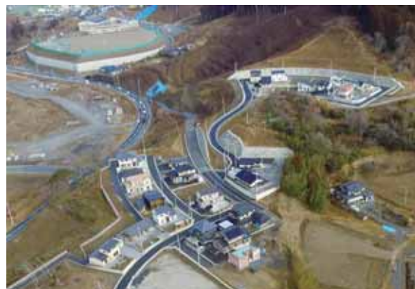
住宅建築が進む永浜地区防災集団移転住宅団地
