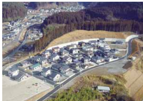
住宅建築が進む中赤崎地区(森っこ)防災集団移転住宅団地
