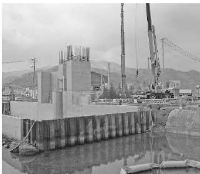
復興事業後の市内の公共工事は
