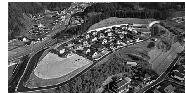
中赤崎その1(森っこ)防災集団移転住宅団地
