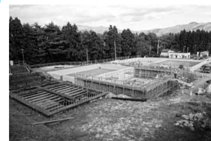
老朽化した第1浄水場の改修工事
