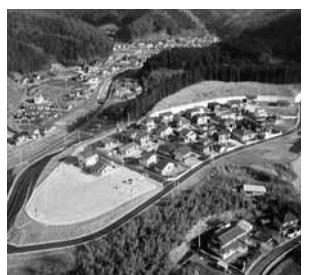
中赤崎その1(森っこ) 防災集団移転住宅団地
