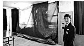
台風被害を受けた 鋸南中学校
