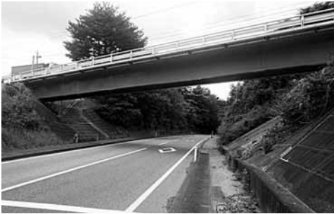
耐震補強工事が完了した吉浜こ道橋
