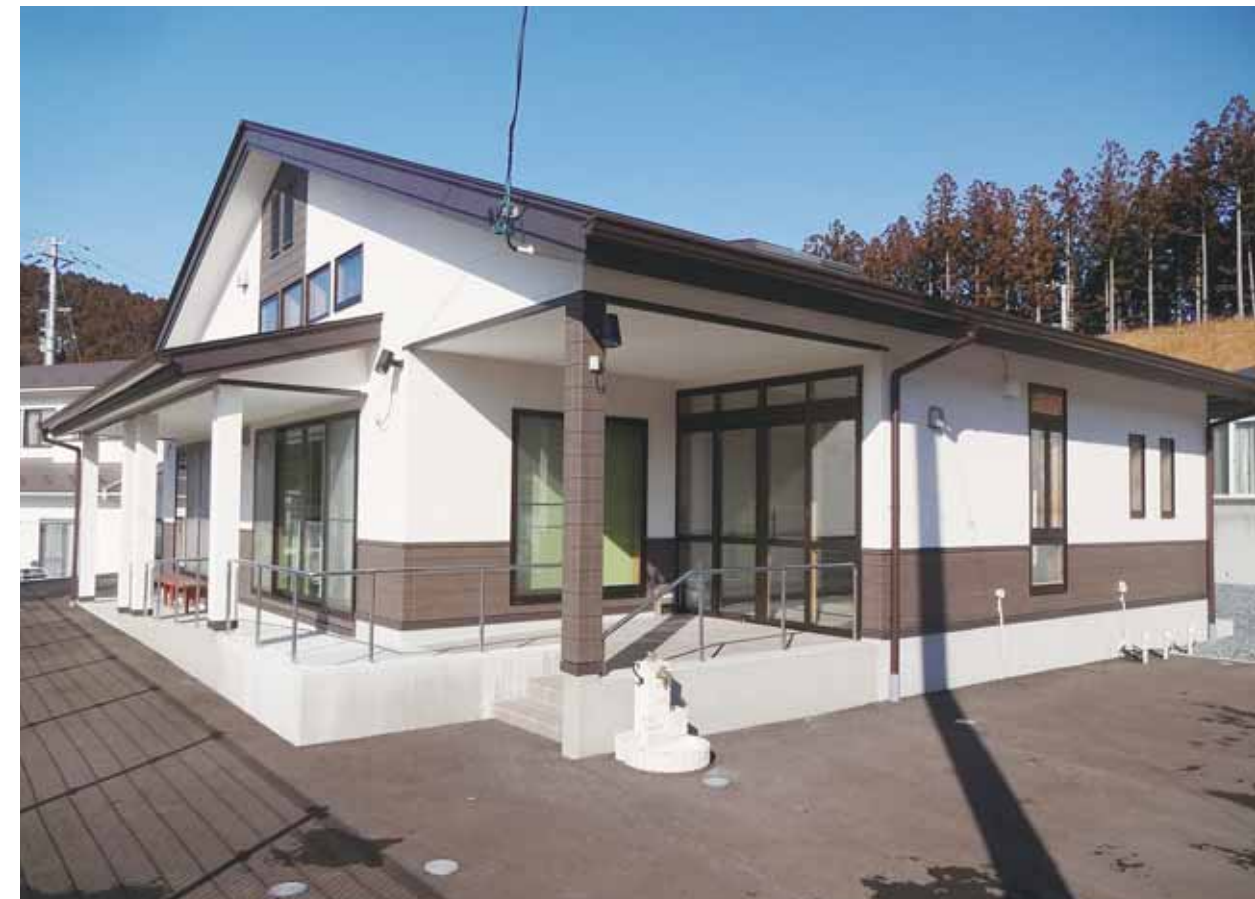
中赤崎地区(森っこ)に建設された集会施設
