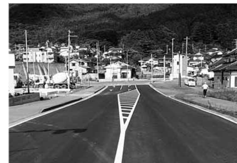
【市道田茂山佐野線舗装修繕工事】
