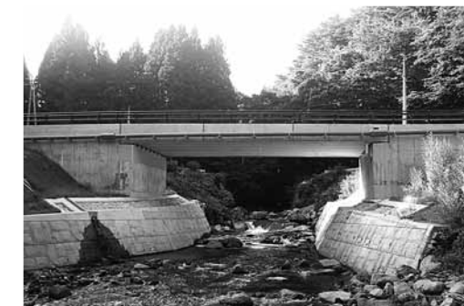
【桃の木渡橋橋梁修繕工事】
