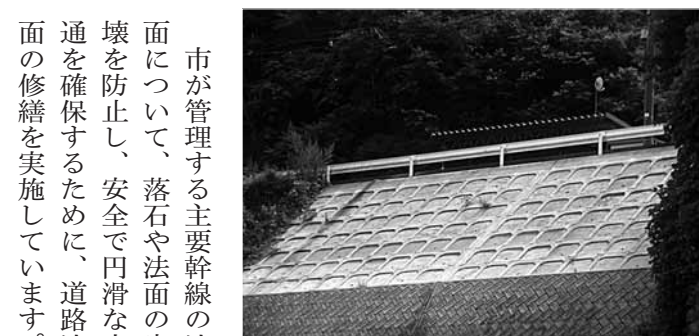
【市道笹崎下船渡線法面修繕工事】
