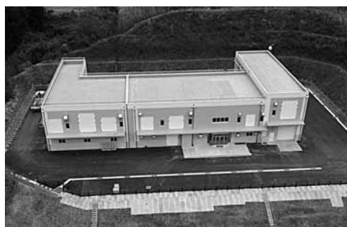
完成した第4浄水場
