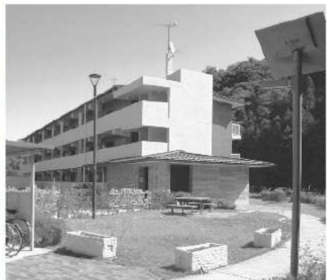
災害公営住宅
