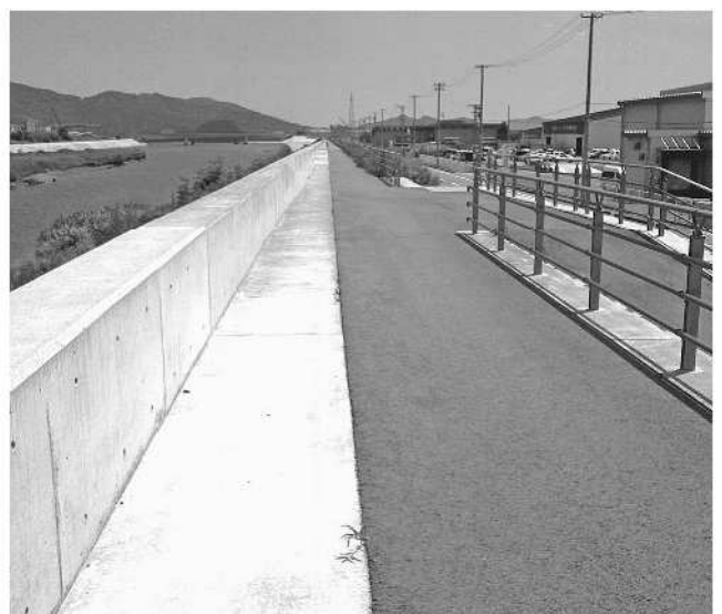
盛川右岸の嵩上げ状況
