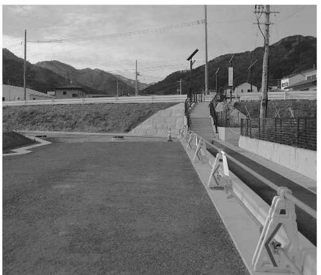
旧台町踏切付近
