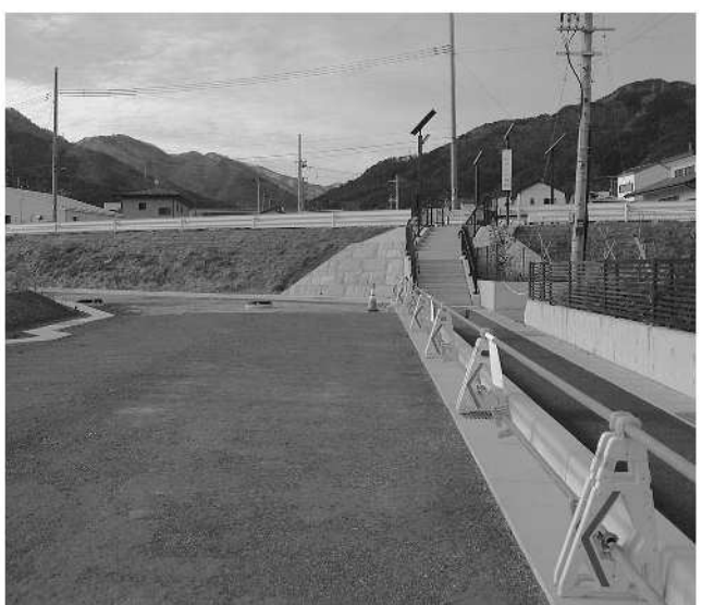
旧台町踏切付近
