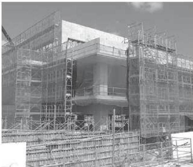
工事が進む津波防災拠点施設
