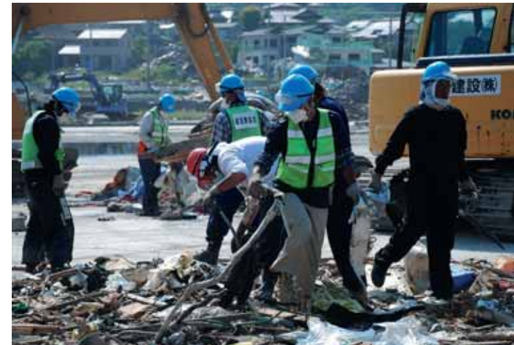
がれきは、手選別と重機選別による一次選別をした後、現在の永浜・山口地区工業用地の二次選別所に運ばれた
