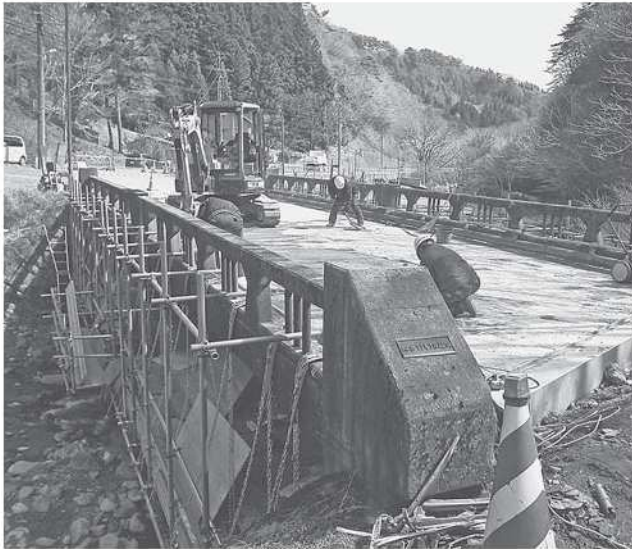
市道路橋の維持補修工事
