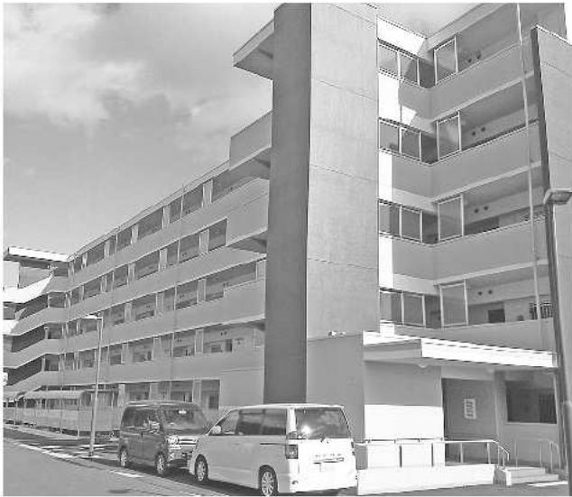
整備が完了した災害公営住宅
