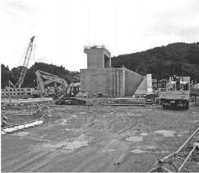
防潮堤の復旧工事
