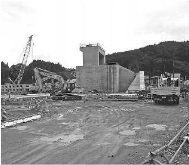
防潮堤の復旧工事
