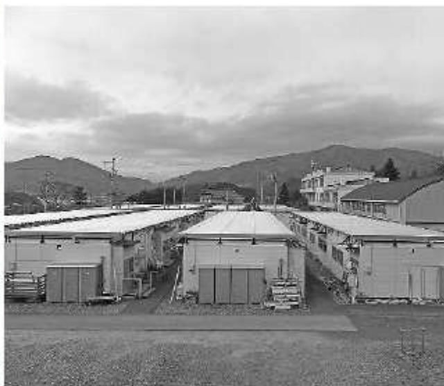
応急仮設住宅
