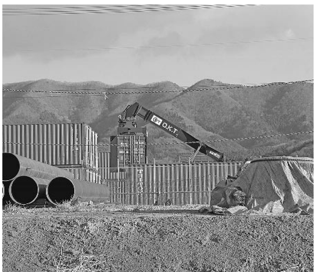
場内でのコンテナ運搬中の様子
