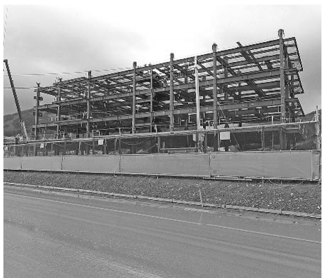
津波復興拠点での建設中の様子
