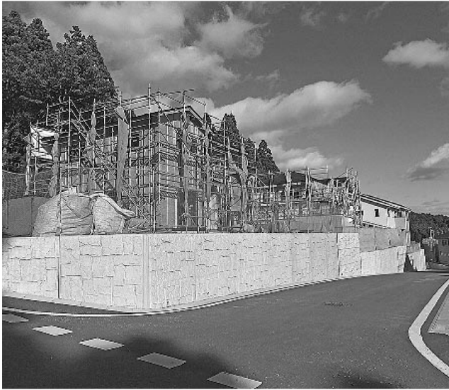
建設中の高台移転住宅
