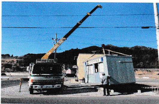
プレハブの吊り上げ
