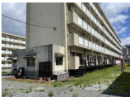
【センターの外観】
