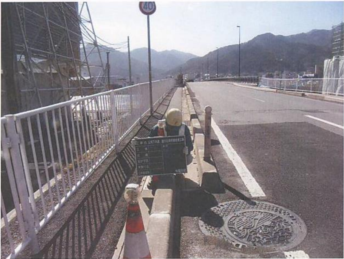
【マンホール工】
