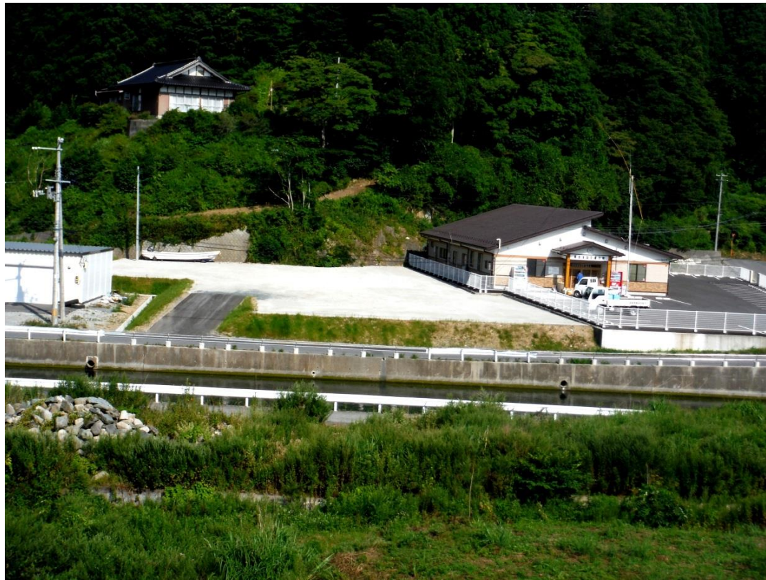
1 期水産用地造成工事 完了状況
