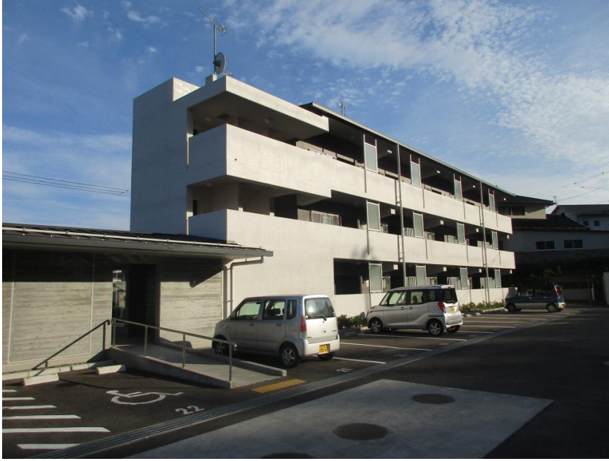
【平林団地 駐車場】
