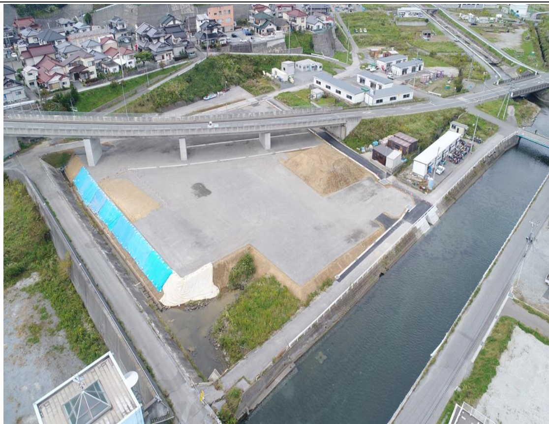
2 期水産用地造成工事 完了状況
