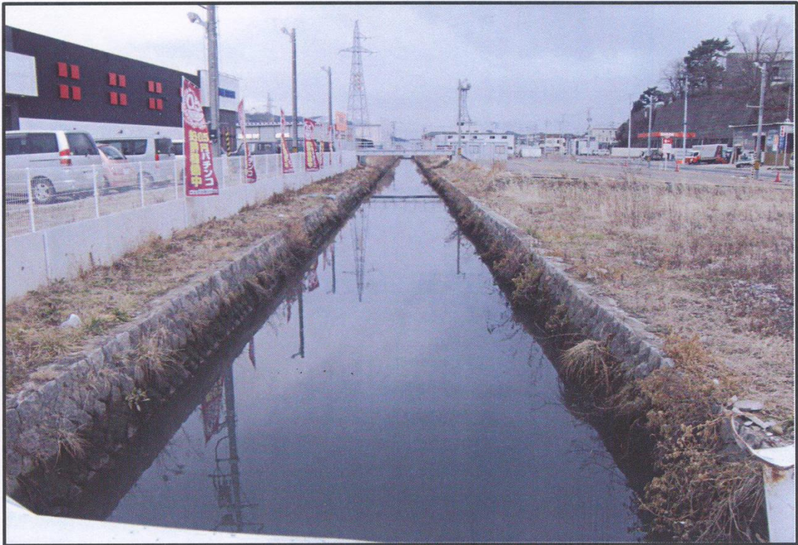
【嵩上げ工事前 ①】
