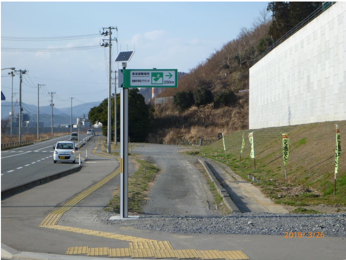
【太陽電池式誘導標識】
