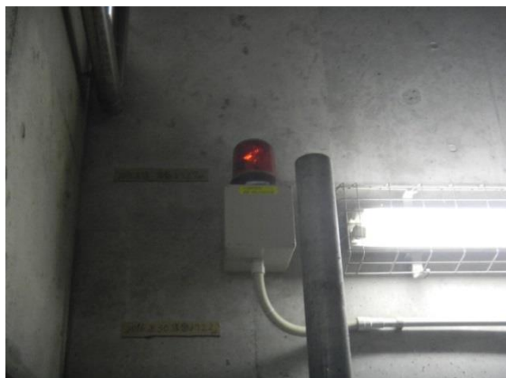
⑤反応タンク地下坑道内／回転灯（2台）
