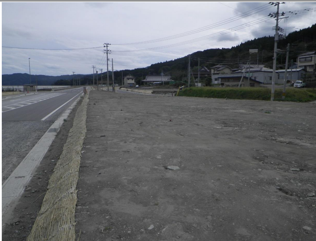
浦浜地区土地利用高度化再編整備工事 完成後
