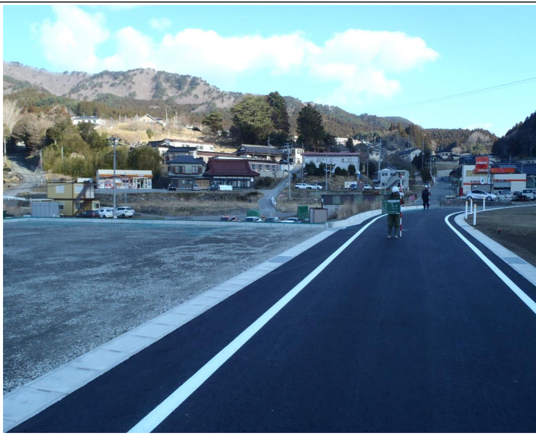
崎浜地区土地利用高度化再編整備 1 期工事 完成後
