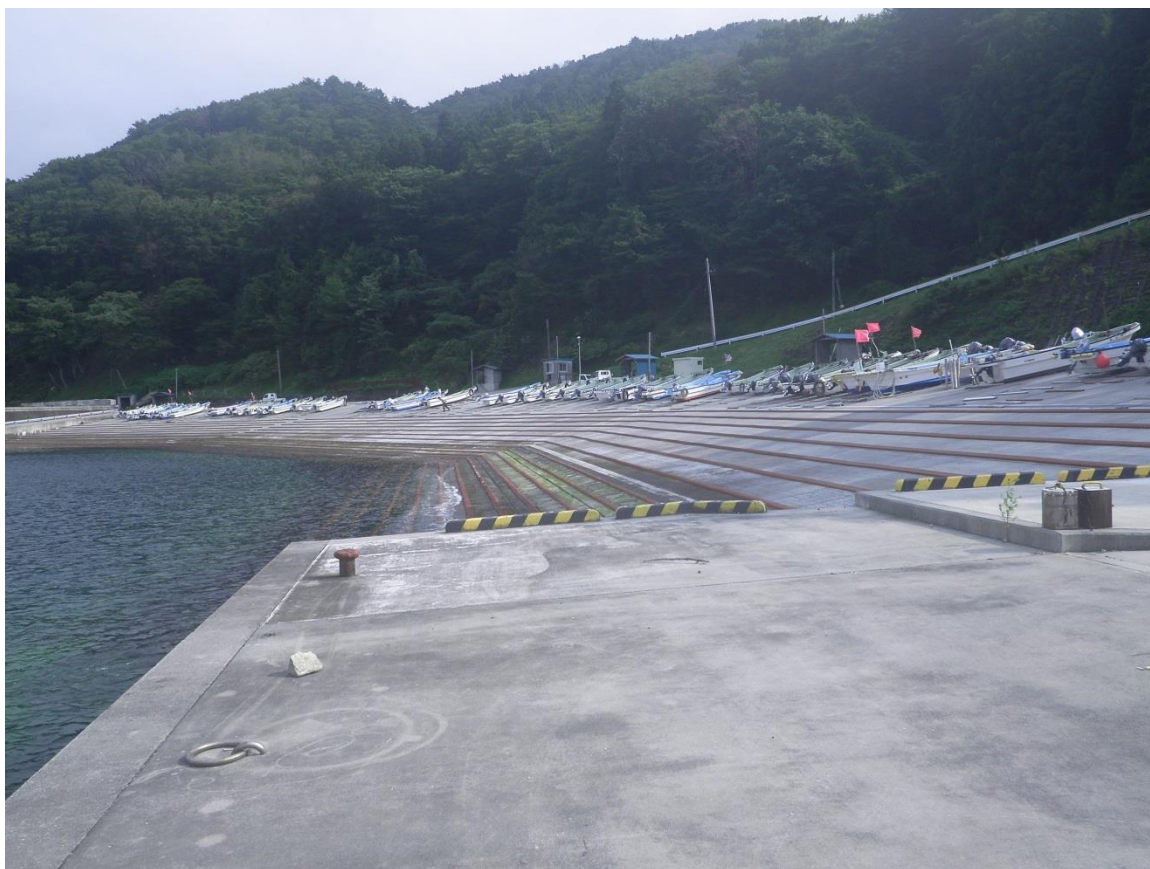
【吉浜漁港船揚場整備後の利用状況】
