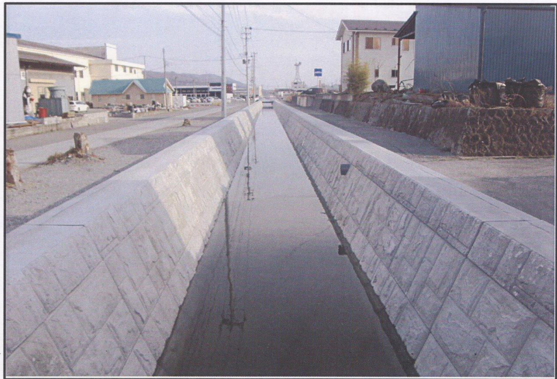
【嵩上げ工事後②】
