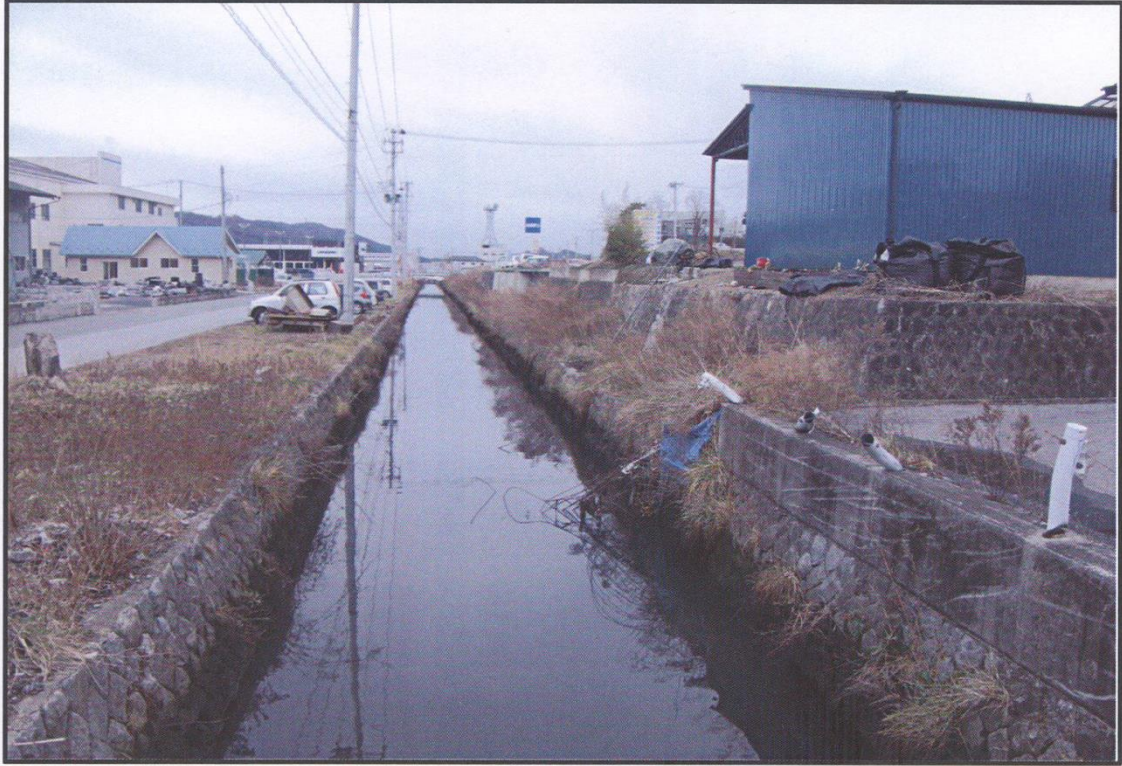
【嵩上げ工事前②】
