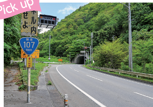
国道107号白石峠区間改良整備の早期着工や(仮称)大船渡内陸道路の高規格化の早期実現のため、国・県への働きかけを強化します。
