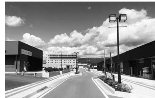
津波復興拠点区域の一部区域は無電柱化で街並みの整備を進めました
