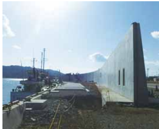
茶屋前地区の防潮堤工事
