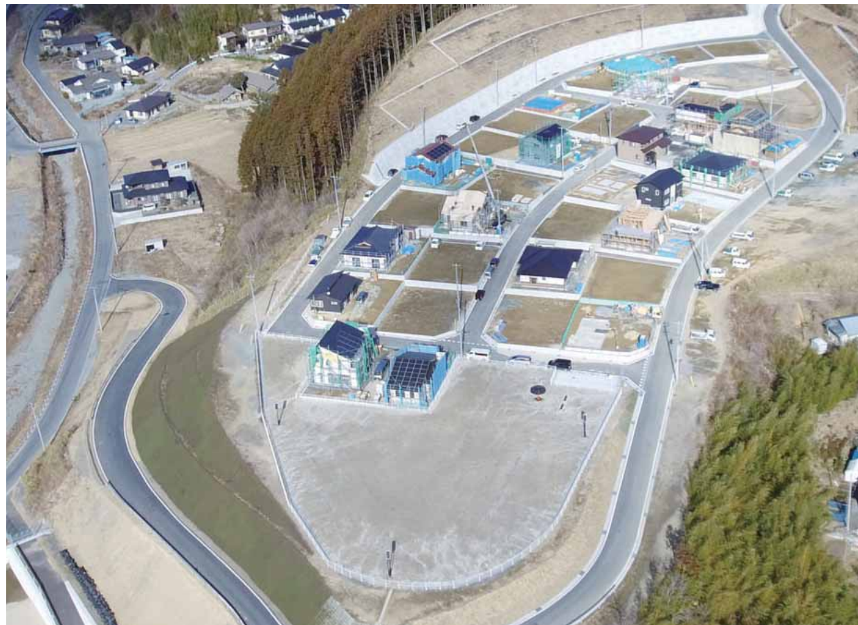
住宅建築が進む中赤崎地区(森っこ)防災集団移転住宅団地
