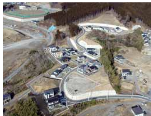
住宅建築が進む永浜地区防災集団移転住宅団地
