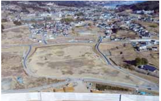
②敷地造成工事が完成した小河原地区の産業用地
