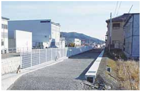
①水路・市道・橋りよりの改修工事を進める地ノ森地区
