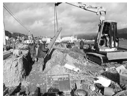
配水管布設替えの様子
