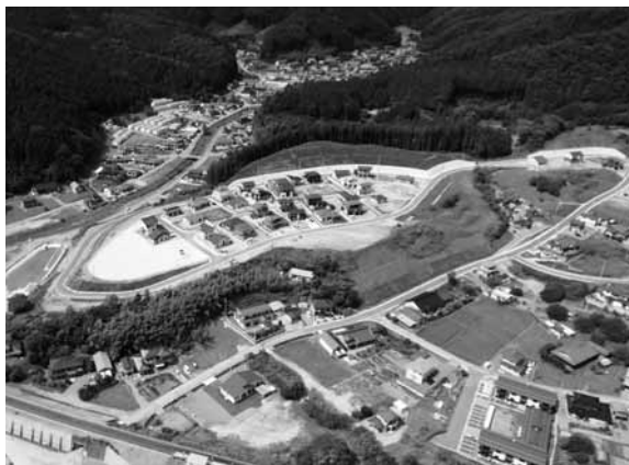
住宅団地整備工事が完成した中赤崎(森っこ)地区
