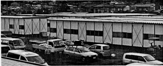
県立大船渡病院跡地に建設されている 応急仮設住宅
