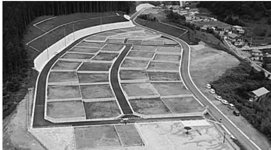
9月5日に工事が完了した中赤崎【森っこ】地区
