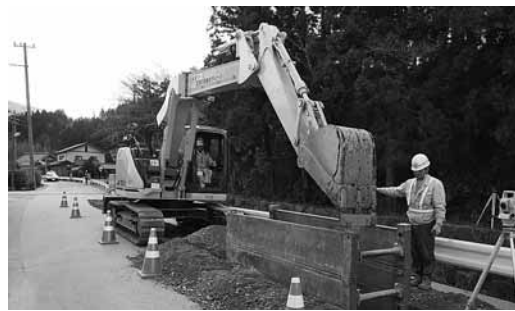
下水道工事の様子
