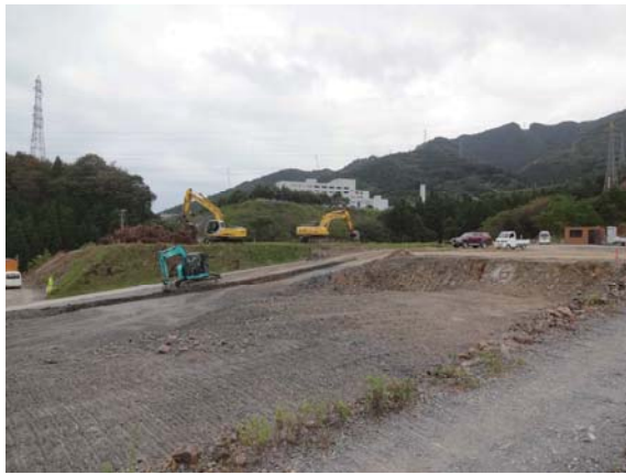
事業名 防災集団移転促進事業（大船渡地区 下館下） 平成26年10月2日撮影
