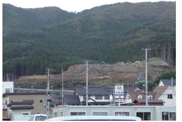
事業名 被災学校移転改築事業（越喜来小学校） 平成26年8月24日撮影
