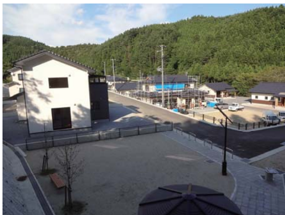
事業名 防災集団移転促進事業（泊地区） 平成26年9月22日撮影
