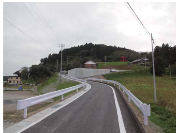
事業名 防災集団移転促進事業（永浜地区） 平成26年10月2日撮影
