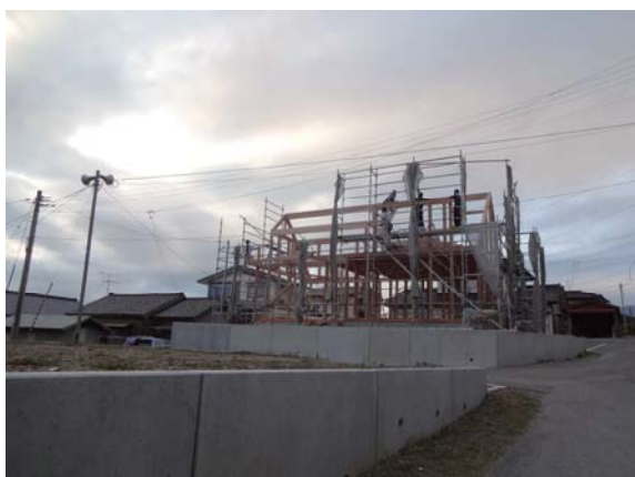
事業名 防災集団移転促進事業（佐野地区③④） 平成26年10月1日撮影
