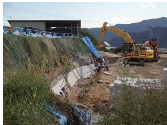
事業名 防災集団移転促進事業（浦浜東・甫嶺地区） 平成26年9月22日撮影
