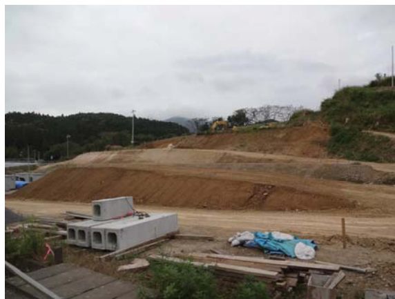
事業名 防災集団移転促進事業（中赤崎地区 駅周辺） 平成26年10月2日撮影
