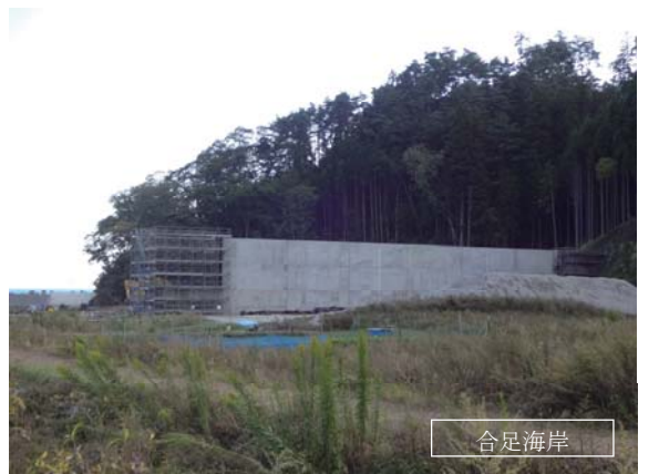
事業名 県 海岸保全施設災害復旧事業 平成26年10月7日撮影
