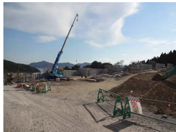
事業名 防災集団移転促進事業（崎浜地区） 平成26年9月22日撮影
