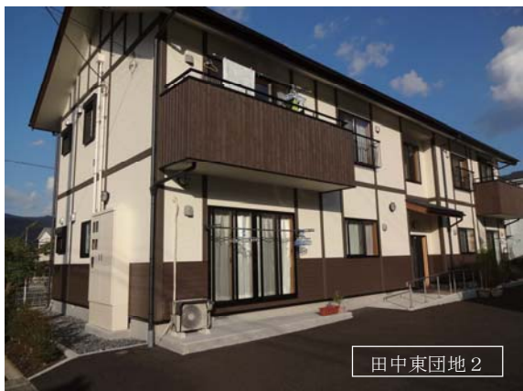
事業名 災害公営住宅整備事業 平成26年10月7日撮影
