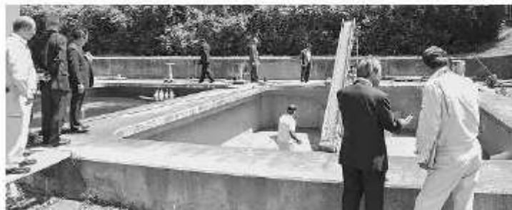
▲砂上げや洗砂を行っている本郷浄水場を現地調査
